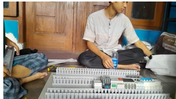
Gambar 2. Proses instalasi sistem ATS
