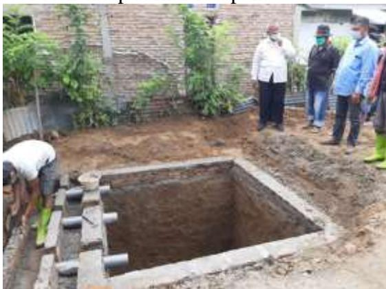
Gambar 8. Pemasangan batu bata sumur resapan
