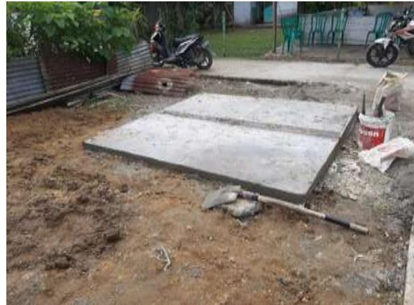
Gambar 9. Tutup sumur resapan dengan cor
