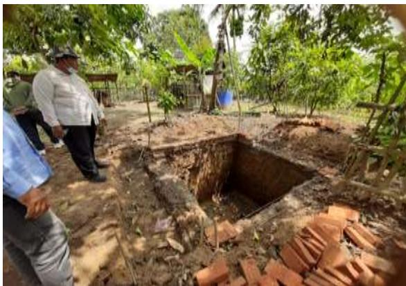
Gambar 7. Pembuatan lubang sumur resapan
