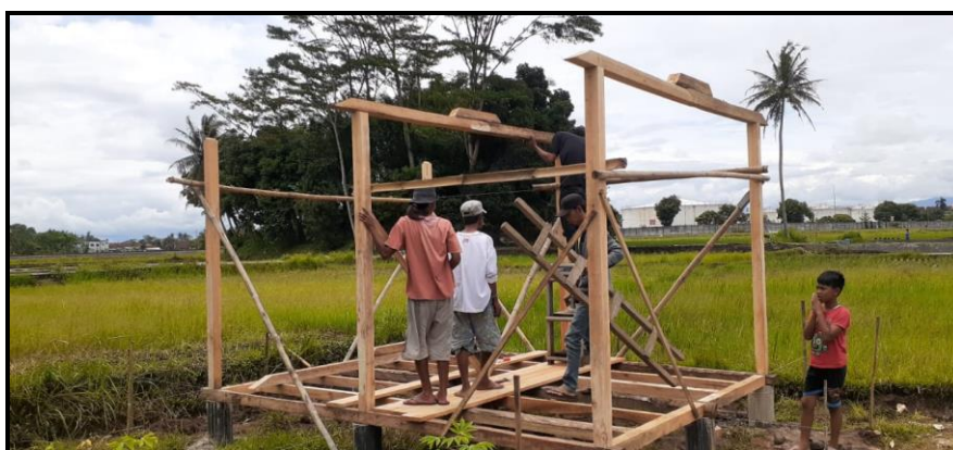
Gambar 2. Proses pembangunan sarana saung dan gudang Sumber Gambar : Dokumentasi perusahaan
