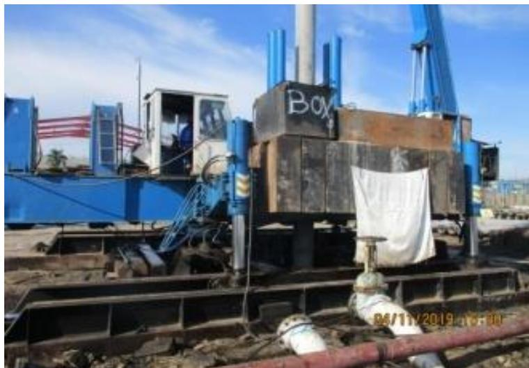
Gambar 2: Alat HSPD untuk pemancangan pondasi
