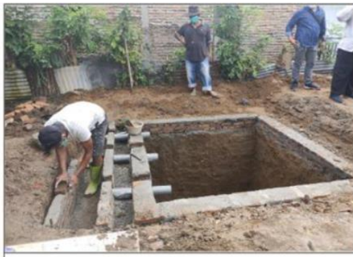
Gambar 4. Pembuatan sumur resapan di Nagori Rukun Mulyo Kec. Panombean Panei Kab. Simalungun
