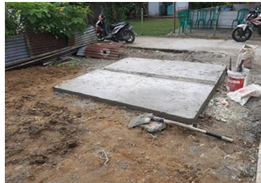
Gambar 4. Pembuatan sumur resapan di Nagori Rukun Mulyo Kec. Panombean Panei Kab. Simalungun
