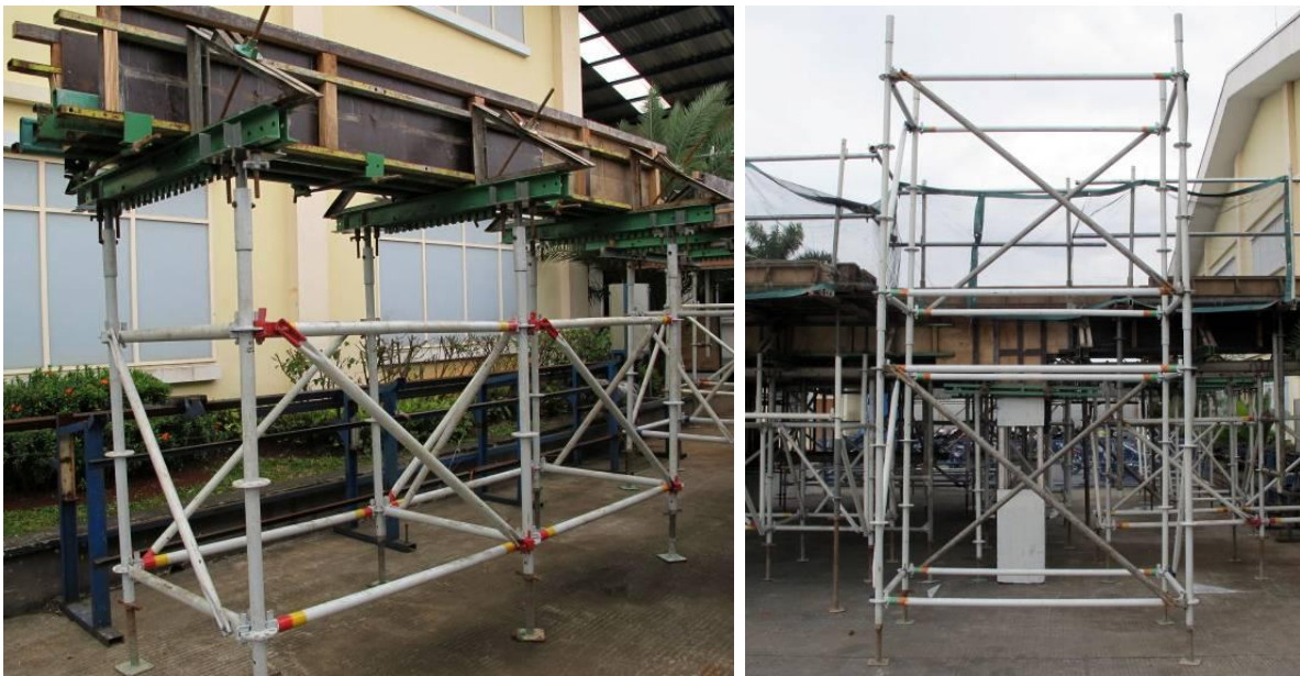
Gambar 30: Tipe scaffolding produksi PT. Putracipta Jayasentosa (Dewobroto, 2013a)
