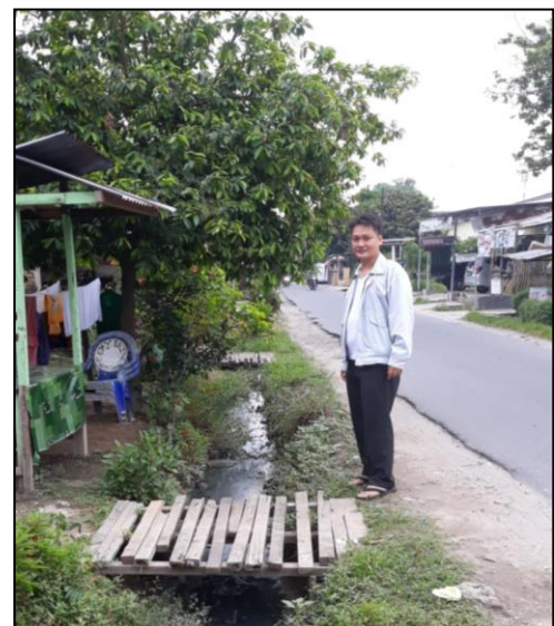
Gambar 2. Lokasi saluran drainase (Sumber: Photo pribadi).
